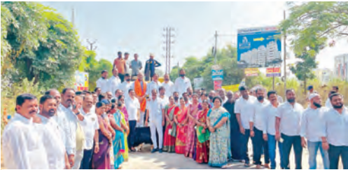
రోడ్డు నిర్మాణ పనులకు భూమిపూజ చేసిన నియోజక వర్గ కాంగ్రెస్ ఇంఛార్జి వజ్రేశ్ యాదవ్.
